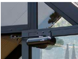
開けたまま固定でき、閉め忘れも防げるドアクローザー。
